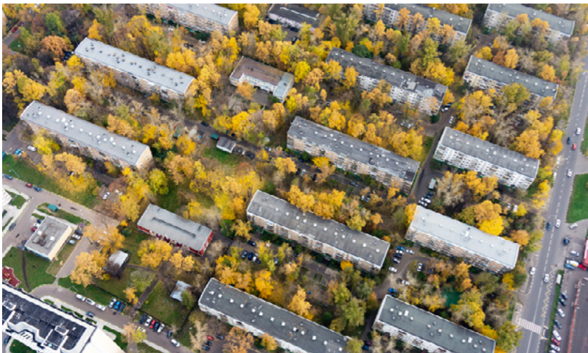
Микрорайонная застройка, г. Москва
